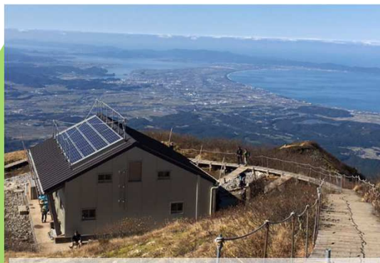
山頂避難小屋改修 (収容人員増、トイレ洋式化)
