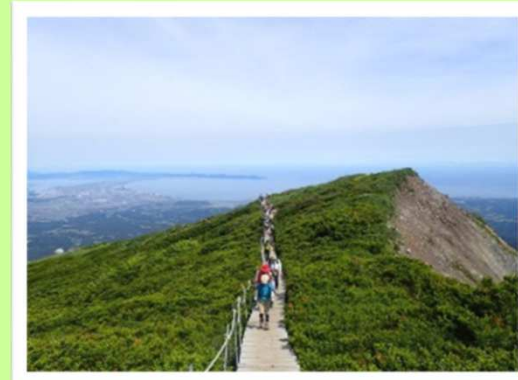
山頂木道の付替え改修
