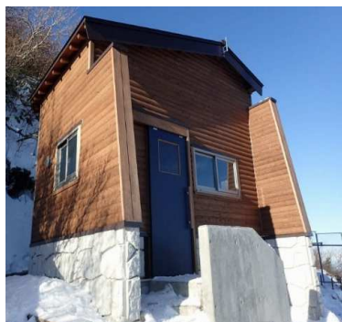
六合目避難小屋改修 (2階化、携帯トイレブース等)
