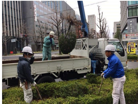
クレーン車による撤去作業
